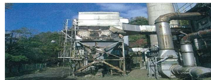
老朽化して休止した処理施設
