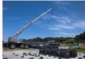
除去土壌等の搬出の様子
