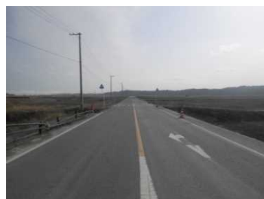
撤去後（平成28年3月）
