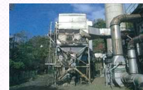
老朽化した廃棄物処理施設の更新
