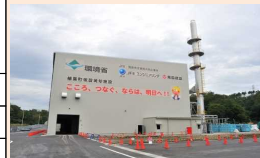
楢葉町の仮設焼却施設 (平成28年10月)
