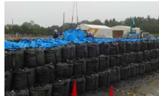
保管場への定置作業
