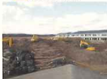
撤去前(平成26年1月)
