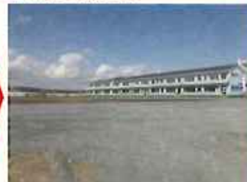
撤去後(平成27年3月)
