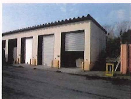
写真 2.4.1 保管庫の外観の例
