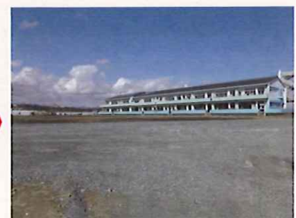
撤去後(平成27年3月)
