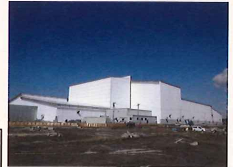
富岡町における仮設焼却施設の建設状況(平成27年3月)
