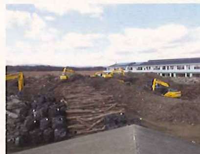
撤去前(平成26年1月)
