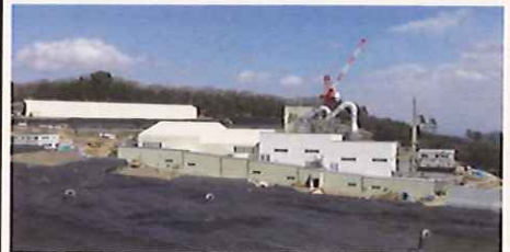
葛尾村における仮設焼却施設の建設状況(平成27年3月)
