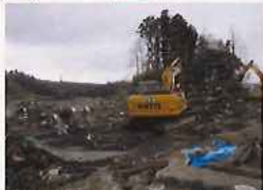
富岡町における津波がれきの撤去状況 (平成27年1月)
