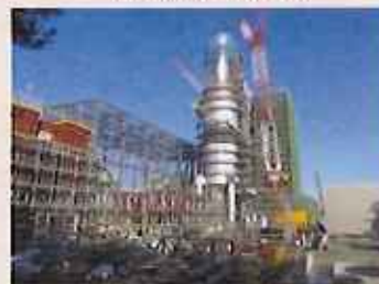
南相馬市における仮設焼却施設の建設状況 (平成27年1月)
