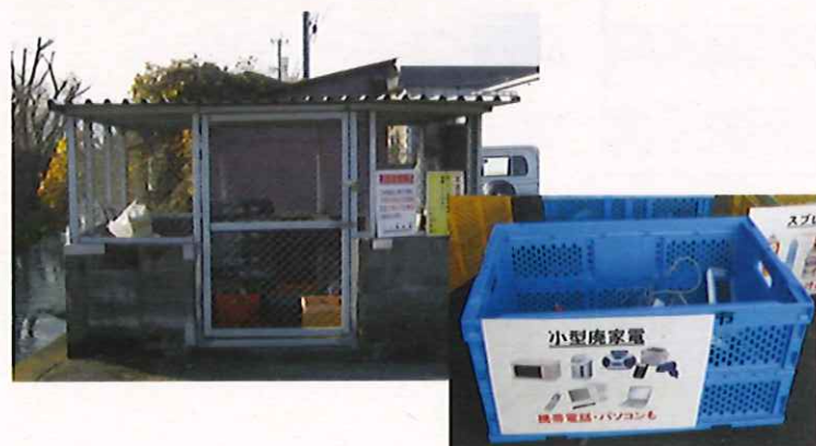
ステーション・コンテナの設置例
