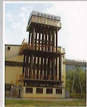
コンデンサータワー
