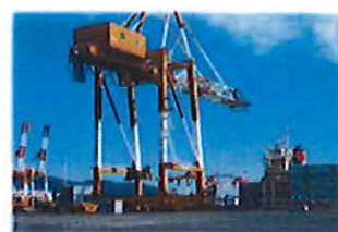
ガントリークレーン
