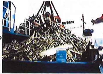
運搬船へ積み込み
