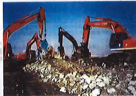
埋立地でのコンクリート殻 分別⇒処分
