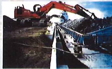
埋立地における陸揚げ状況
