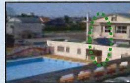
■太陽熱利用型 太陽熱をプールの温水 シャワーに利用
