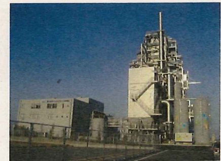
岩国ウッドパワー殿 (木質バイオマス)
