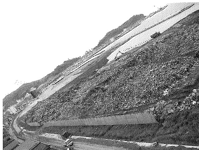
写真1 仮置場の様子
