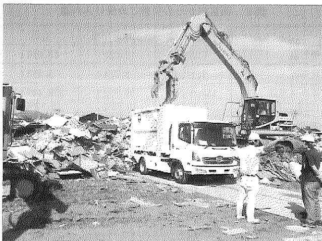
写真1 災害廃棄物をコンテナに積み込む状況
