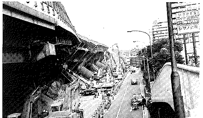
阪神高速道路の倒壊現場(撮影：藤永のぶよ)
