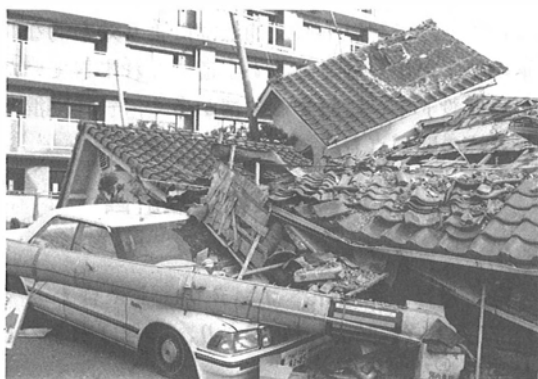
写真1 倒壊した民家
