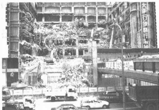
写真3 解体中のビルディング
