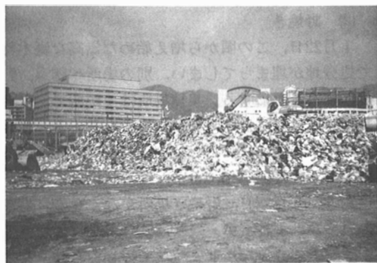
写真2 小野浜中継地（中央区）
