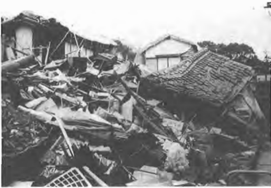
写真6 北淡町富島地区での倒壊家屋
