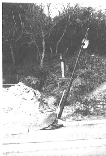
写真5 震源地近くでの被災状況
