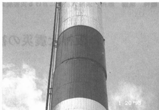
写真2 横にずれた焼却施設の煙突
