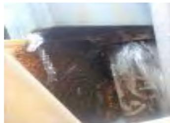
浄化槽の劣化(鋼管製バルブの腐食)
